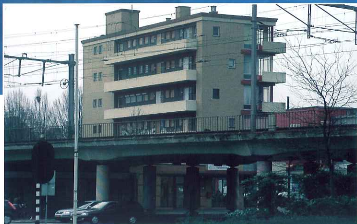
Flat Roermondsepoort te Venlo, gelegen temidden van spoorlijnen en wegen. De geluidsbelasting op de gevels varieert van 78 tot 79 dB(A).
