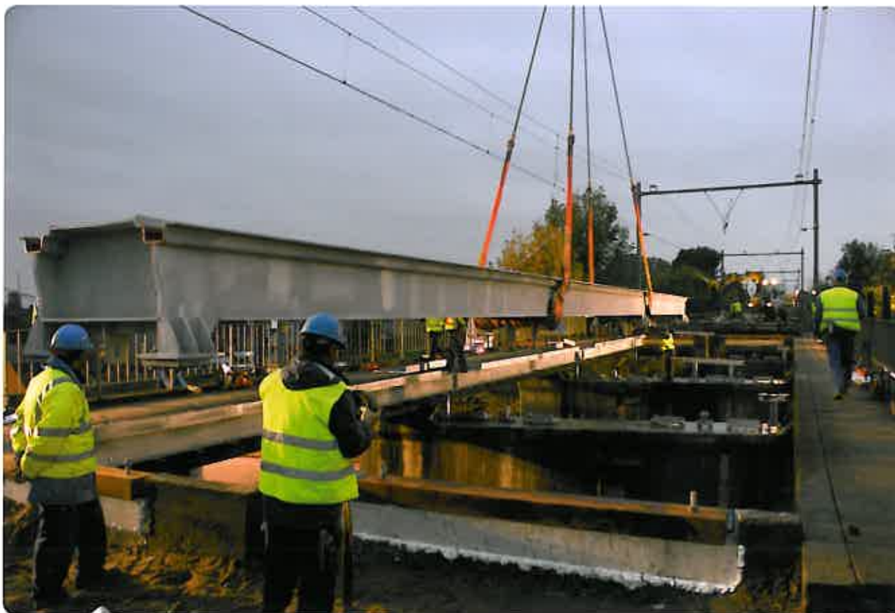
In oktober 2009 werden in Waardenburg, gemeente Neerijnen, op de spoorlijn Utrecht – Den Bosch, twee stalen spoorbruggen vervangen door stillere bruggen. Ook werden geluidsschermen geplaatst met een totale lengte van 1.750 meter. Met deze maatregelen werden 175 woningen gesaneerd. De schermen en bruggen zijn geheel gefinancierd met saneringssubsidie.
