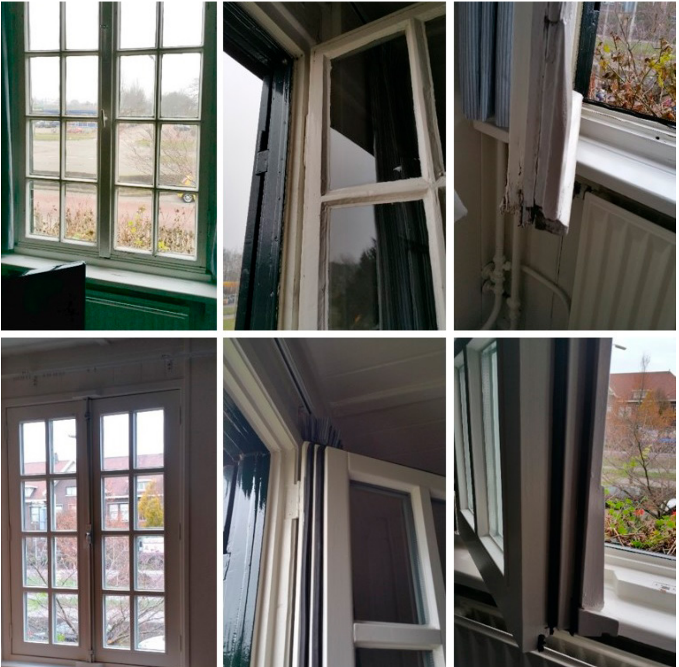
Raam voor (boven) en na (onder) gevelisolatie
