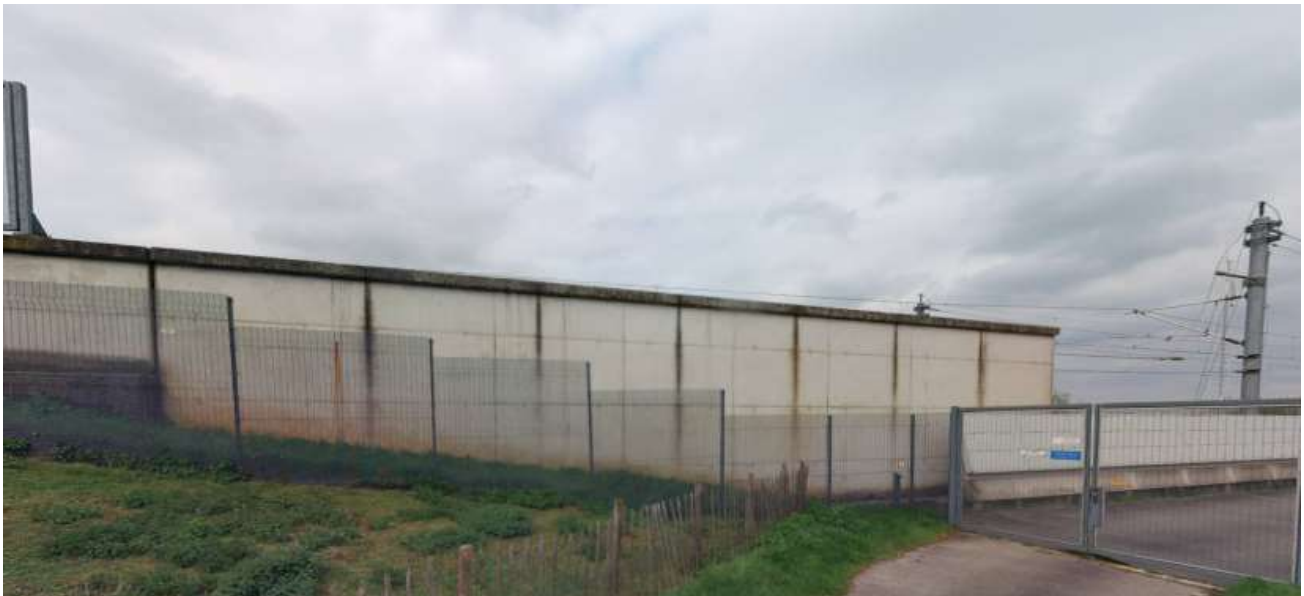
Afbeelding 4-1 verhoogde keewand bij tunnelmond, noordzijde Oude Maas bij de Lindtsedijk
